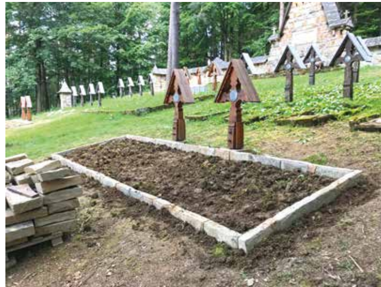
Verlegung neuer Bordsteinkanten bei den Gräbern am Kriegerfriedhof Nr. 61 Wirchne
